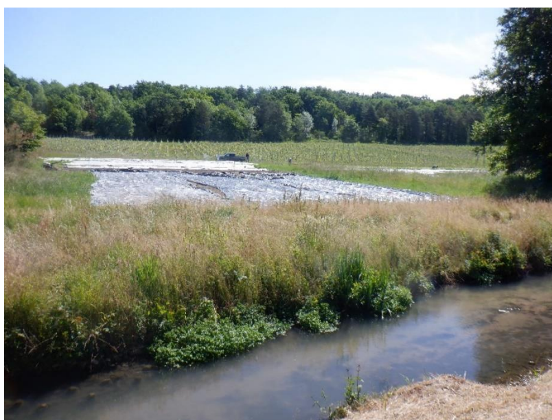
Photo 1 : Vue générale du contexte dans lequel se trouve la station
