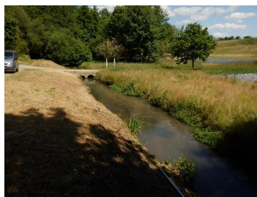
Photo 3 : Vue générale de la station, en aval
